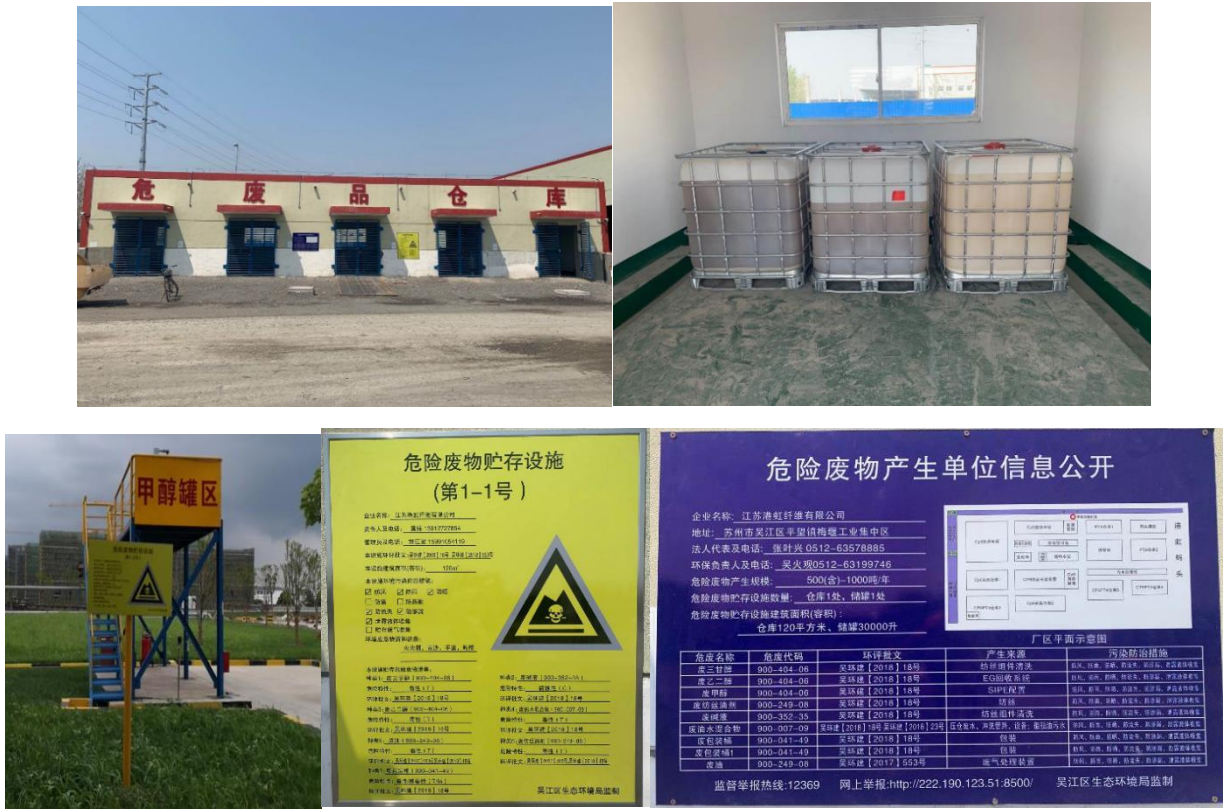
图 3.1-7 厂区危废贮存设施现场照片
